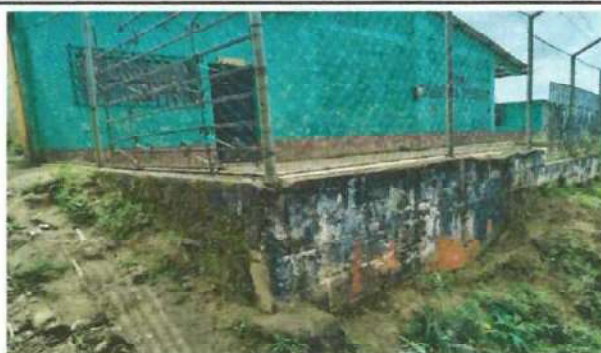
Foto 5: Sustitución de muro perimetral por deterioro en su estructura.
