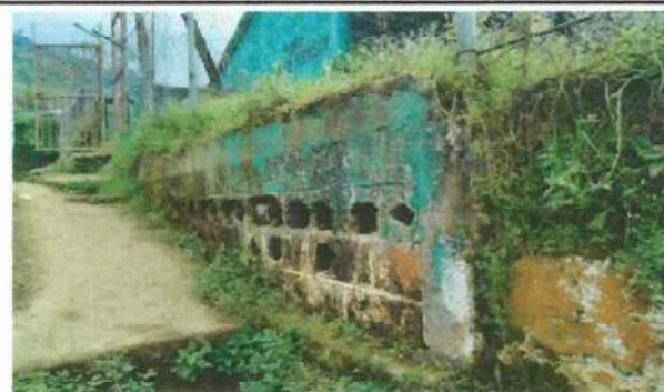
Foto 6: Reparación del muro de contención con reforzamiento de base y aplicación de sabieta
